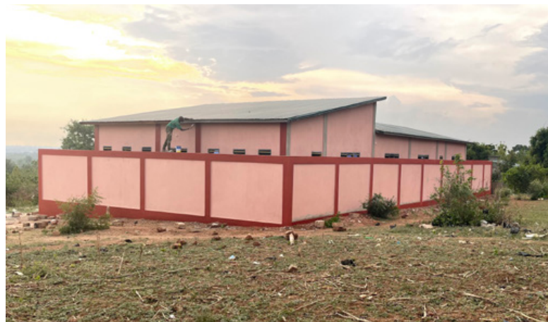
Private Spenden machen es möglich: das neue Mädchenhaus ist bezugsfertig! Es steht unweit des Projektes auf einer Anhöhe oberhalb von Dogbo.
