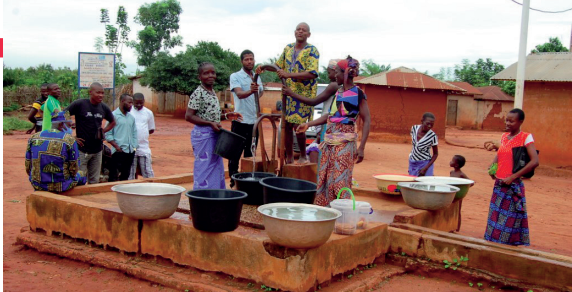
Die Wasserstelle eines reparierten Brunnens in der Kommune Dogbo wird nun wieder von der Dorfbevölkerung genutzt.
